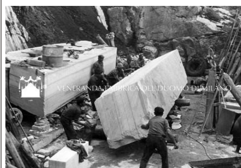
Foto d'epoca – Movimentazione dei blocchi
